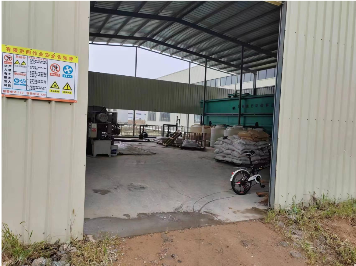
图2-2 污水处理设施
