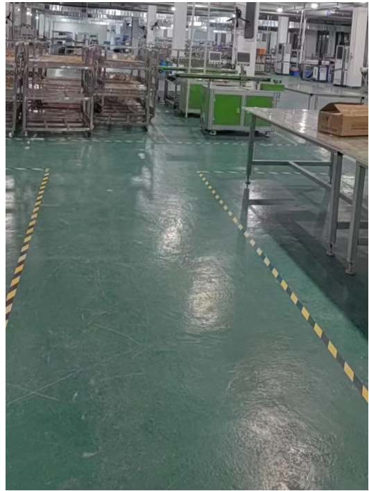
生产车间地面
